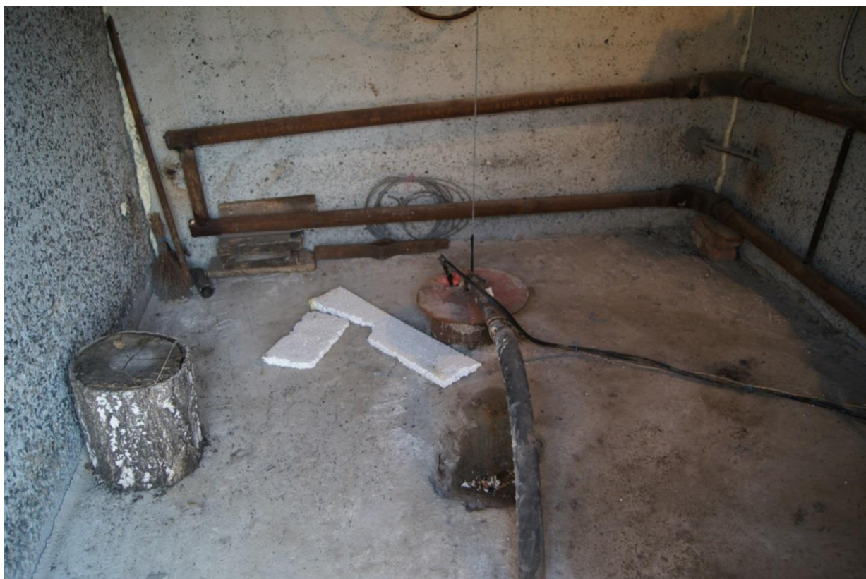
Рисунок 2.2 – Павильон скважины № 38 «Г» системы централизованного водоснабжения д. Розенталь
