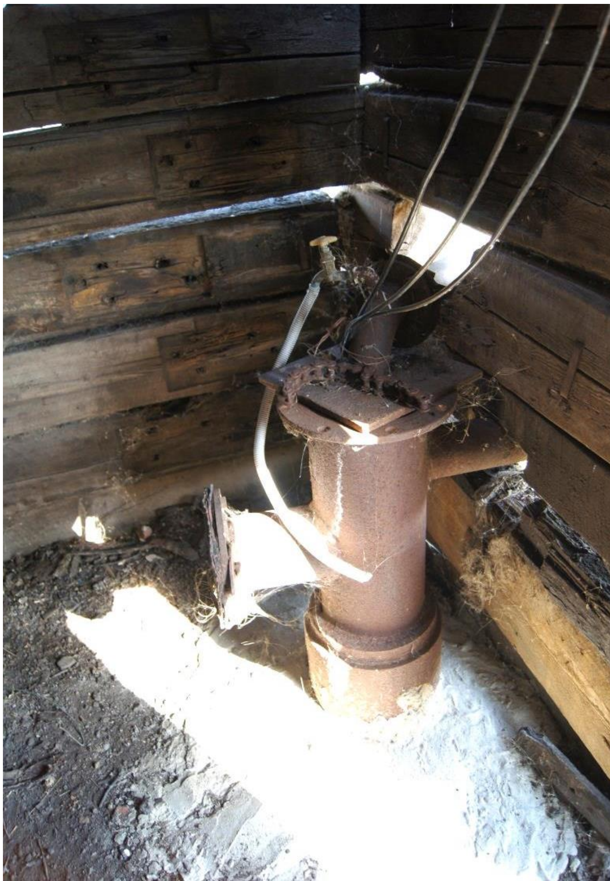
Рисунок 2.3 – Павильон скважины № 170 «Г» системы централизованного водоснабжения с. Козловка
